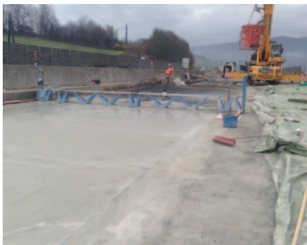
Einsatz von UHPC für die Fahrbahn einer Autobahnbrücke in der Steiermark
