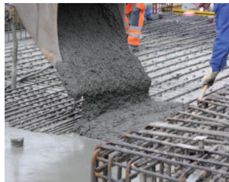
Aufbringung einer ca. 6 cm hohen UHPC Schicht auf Normalbeton zur Erhöhung der Dichtheit und Haltbarkeit einer Eisenbahnbrücke in Kärnten
