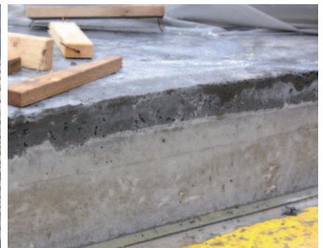
Aufbringung einer ca. 6 cm hohen UHPC Schicht auf Normalbeton zur Erhöhung der Dichtheit und Haltbarkeit einer Eisenbahnbrücke in Kärnten
